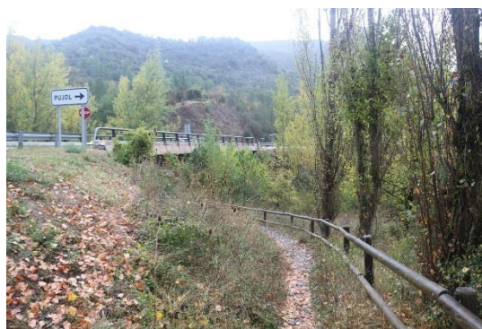
Estat del camí que creua la carretera N-260 i que comunica l'àrea de pícnic/descans de Morreres amb la Georuta II. M. Poyatos.
