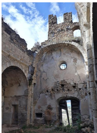
Estat actual de la façana de l'església de Sant Fructuós, al poble d'Aramunt Vell. La fotografia evidencia el seu estat ruïnós. M. Payatos.
