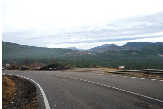
Zona d'aparcament recomanada. És un mirador a salt d'aigua de la Presa de Talarn. J. Panisello.
