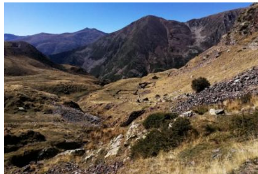
Cases derruïdes utilitzades a principis del S. XX per treballadors de construcció la Central. X. Mir.
