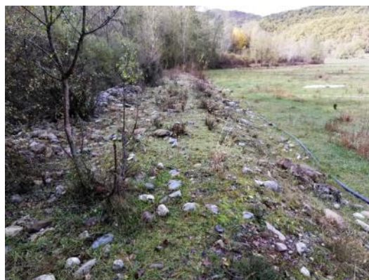
Dic de contenció construït al marge del Riu Flamisell per evitar la inundació dels camps de cultiu. X. Mir.
