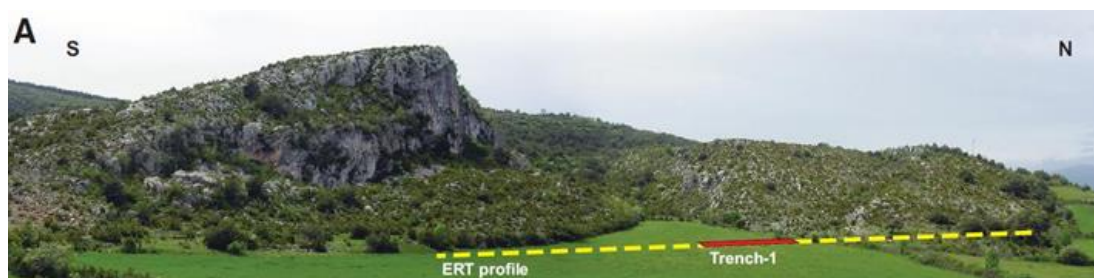
Panoràmica de l'estructura de horst i graben al Roc de Perauba (Gutierrez et al., 2012).
