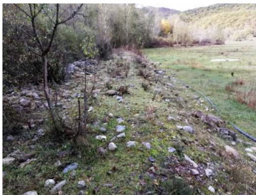
Dic de contenció construït al marge del Riu Flamisell per evitar la inundació dels camps de cultiu. X. Mir.
